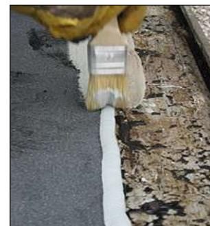
Auf dem rechten Foto sehen Sie die verschiedenen Anwendungsbereiche (Verschraubungen, Stöße, Nähte) die mit der PU-Dichtmasse vorbehandelt werden.
