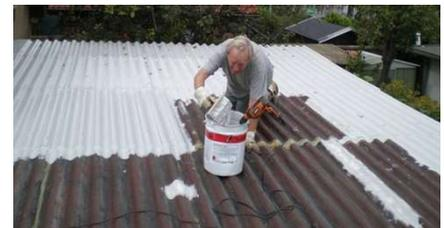
Das Gewebevlies saugt den zuvor aufgetragenen PU-Flüssigkunststoff auf und bildet nach dem Tränken und der Trocknung eine elastisch, dichte Rissbrücke. Auf Grund der Saugfähigkeit benötigt man im Bereich des Gewebevlieses vom **“DIMESEAL® 250 PU-Flüssigkunststoff“** insgesamt ca. 2,5 Kg/m<sup>2</sup> Material, denn das Gewebe benötigt auf Grund seiner Saugfähigkeit entsprechend mehr Material.
