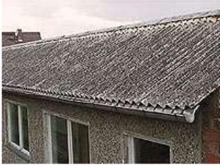
Wellplattendächer gehören zu den kostengünstigen Dachbedeckungen. Da sie schnell und einfach zu montieren sind und eine geringe vorgeschriebene Regeldachneigung von nur 8° Grad benötigen ist ein Vorteil dieser Bedachung.
