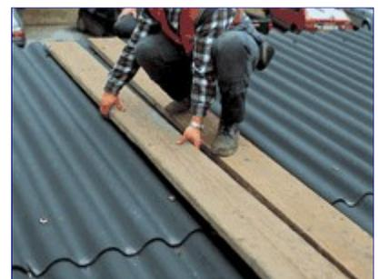
Die Wellplatten müssen fest montiert, trocken und sauber sein (oft genügt das Abkehren). Bei starker Verschmutzung kann ein Hochdruckreiniger eingesetzt werden. Die Fläche muss jedoch anschließend wieder vollkommen trocken sein.
